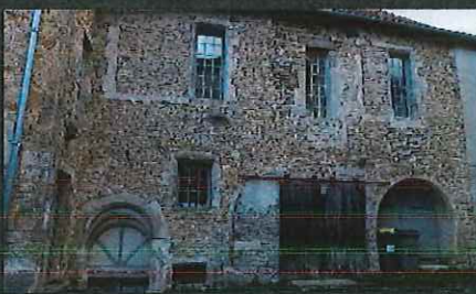
La suppression de la porte coulissante de bois et la refecton de l'enduit améliorerait la lisibilité de la façade
