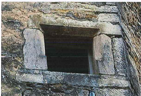
Les murs et les ouvertures font apparaître les modifications intervenues au fil du temps et des divers usages du bâtiment.
