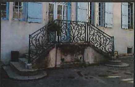
L'escalier donnant sur la cour à valoriser
