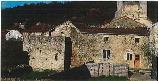
Les vestiges de l'ancien rempart sont inclus dans des habitations.
