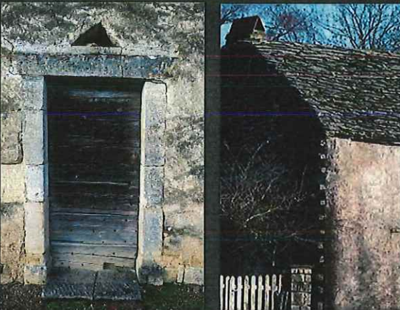
Porte piétonne de bois cloué, angle aux pierres saillantes témoin d'une annexe détruite, cheminée coiffée : des détails qui font la singularité de l'édifice.
