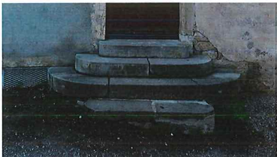
Un soin particulier doit être apporté à l'escalier qui met en valeur l'entrée.
