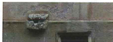
Gouttière de pierre à eau en saillie sur la façade
