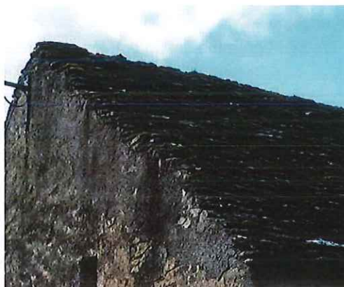
La ruellée maçonnée d'une rive
