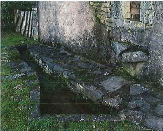
La pierre à eau ainsi que les pierres du caniveau constituent des éléments de patrimoine à préserver.
