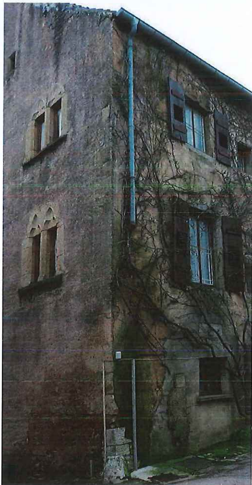
Les baies à menu et linteau trilobé en place témoignent de l'ancienneté de l'édifice.
