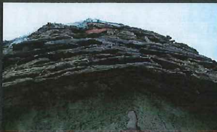
La tour d'escalier coiffée de sa toiture conique en laves est caractéristique à maintenir.
