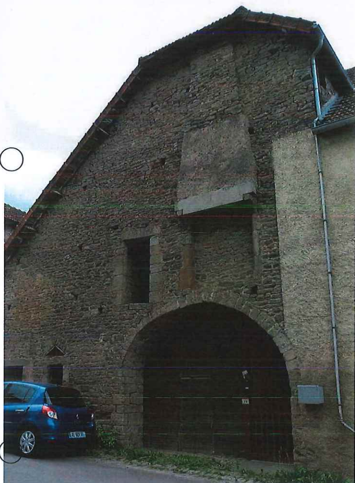
La façade sur la Grande rue est irrégulière, déséquilibrée et constellée de trous de boulin.
