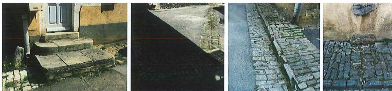
Franchissements et adaptations du caniveau le long des façades : il prend des formes multiples.
