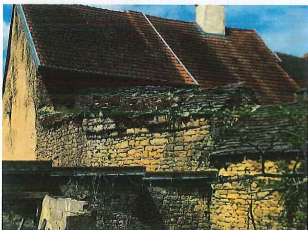
La couverture de laves des vestiges de l'ancien rempart permet leur conservation
