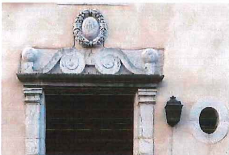
La porte d'entrée est encadrée par des pilastres et un linteau sculpté d'une corniche* et de deux consoles affrontées, surmontées d'une couronne végétale entourant le monogramme IHS.
