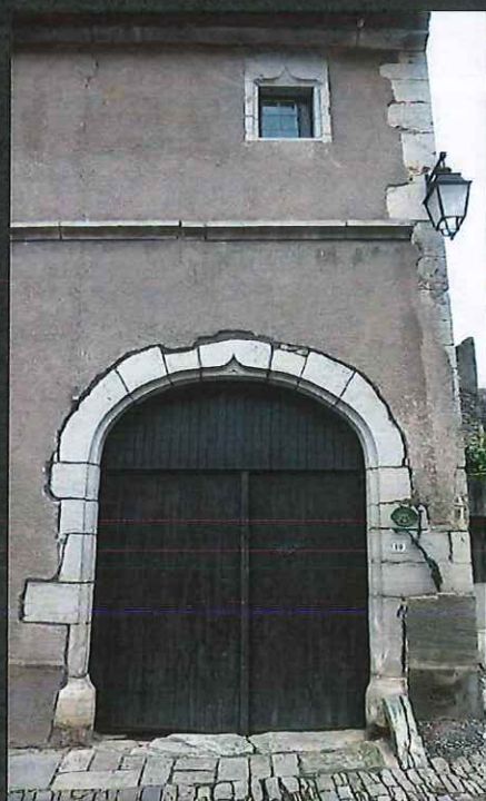
Le modèle classique de la porte de grange, constitué de planches doit être maintenu ou réinterprété avec une composition respectueuse de la sobriété de la porte.
