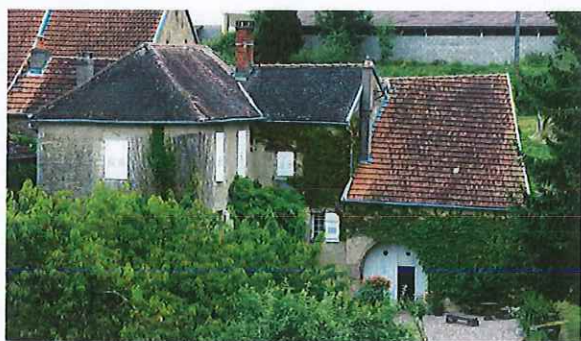
La clôture et la végétation dissimulent le Presbytère.
