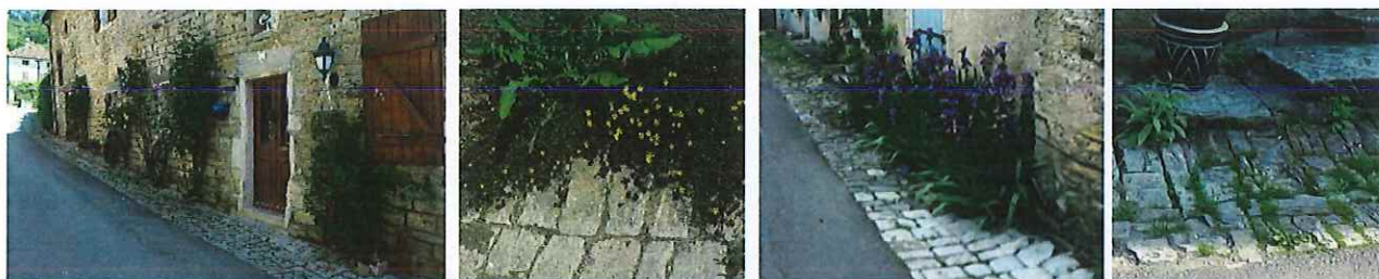
Les interstices entre les pavés permettent d'accueillir une flore spontanée... ou des plantations.
