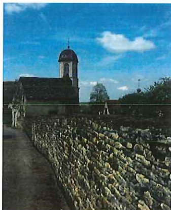
Mur clôturant le jardin du Presbytère
