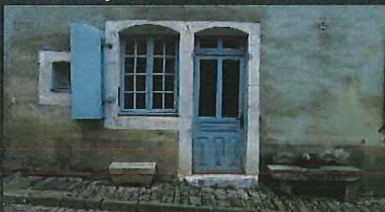
La cohérence d'une façade passe par un traitement adapté au style. Les huisseries, les menuiseries à petits carreaux et les volets de bois sont peints d'une même couleur, en accord avec la teinte de l'enduit.
