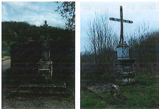
La pierre locale est taillée et sculptée pour constituer la majorité des ouvrages de petit patrimoine. On veillera à utiliser des méthodes non abrasives pour son entretien.
