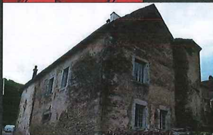
En cas de réalisation de nouvelles ouvertures, l'alignement et la reprise des proportions des fenêtres existantes favorisera une lecture régulière de la façade.
