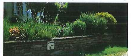
Muret de soutènement dans l'extension villageoise : des abords soignés qui créent une continuité avec le bourg historique.
