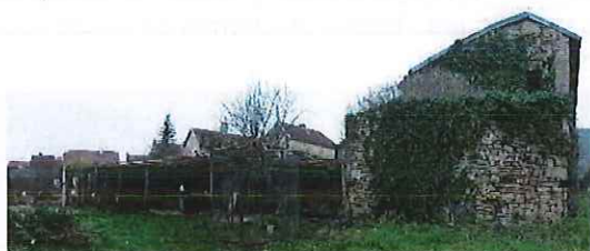
Les apprentis nuisent à la lecture du tracé du rempart, tandis que la végétation envahissante menace la pérennité du mur.
