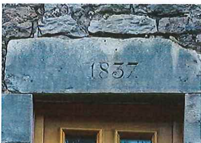
Les parties bouchardées des pierres témoignent qu'elles permettaient l'accroche de l'enduit*.
