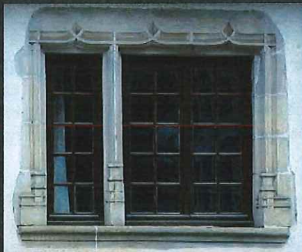
La pierre taillée des encadrements des baies est restée dans un très bon état de conservation. Elle doit être protégée.
