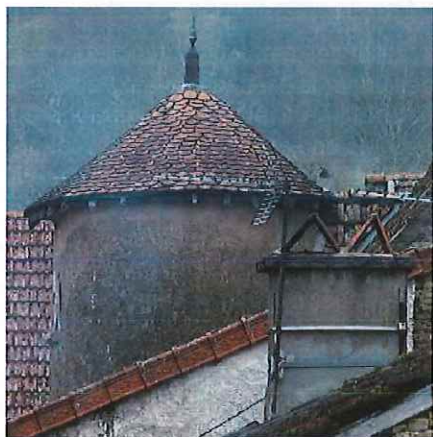
La tour d'escalier de la Grande Maison de Chariez est l'une des dernières demeures à présenter des tuiles en écailles.
