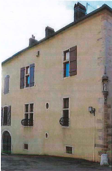
Les grandes baies à croisées* sont imposantes et sont organisées de façon ordonnancée. Ces alignements ont été prolongés lors de l'ajout de deux baies à linteau segmentaire avec agrafe* sur la façade Est.
