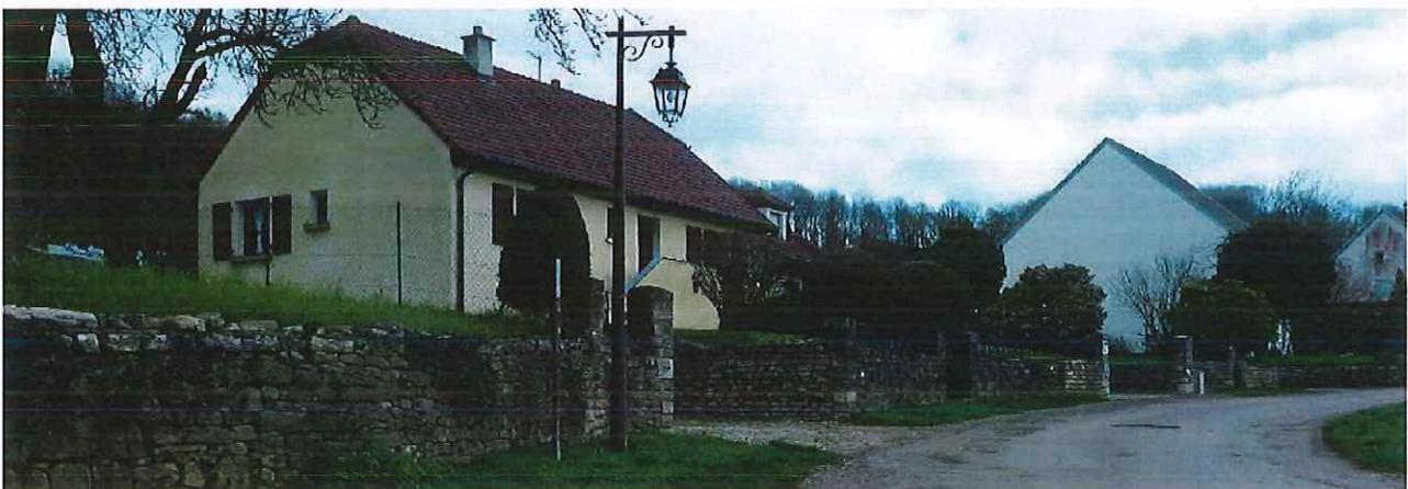
Les murs des soutènements sont réalisés à l'aide de blocs de pierre calcaire locale, laissés apparents
